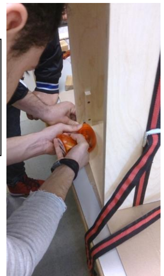
.... und der somit entstehende Rahmen mit Spanngurten im rechten Winkel stabilisiert.
